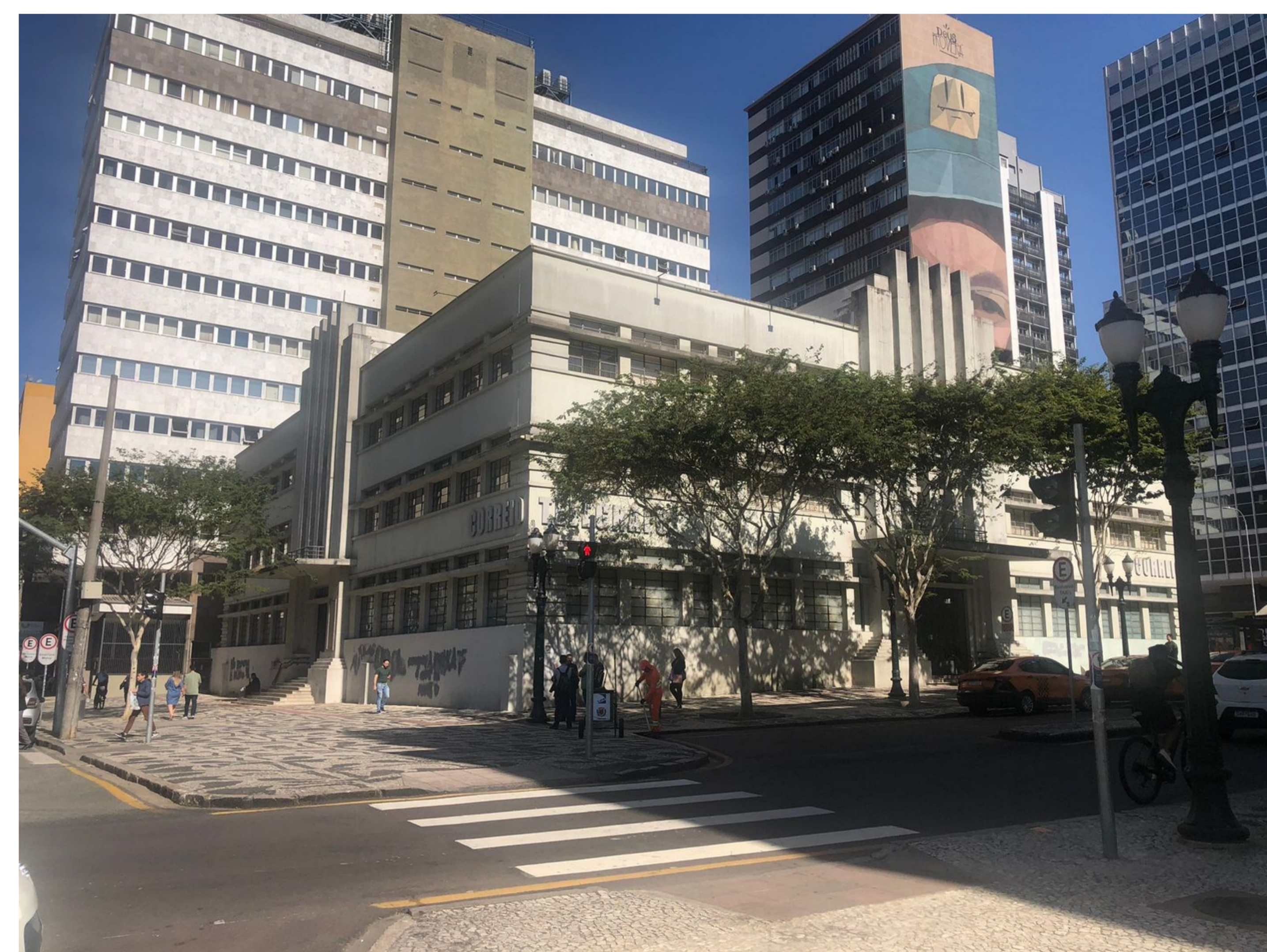
Figura 2. Fachada do Edifício dos Correios em Curitiba- PR. Foto: Ivan Bueno
